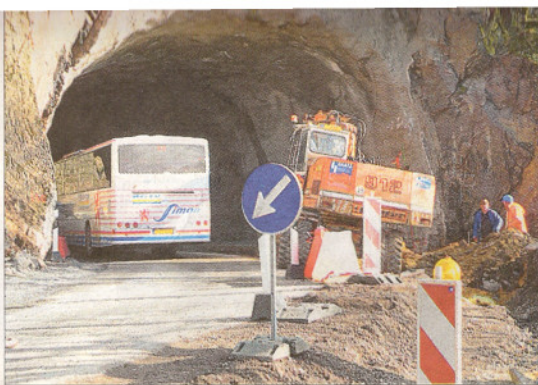
Zwei Portale aus Stahlbeton sollen mögliche Steinschläge an den Eingängen des Tunnels auffangen.
